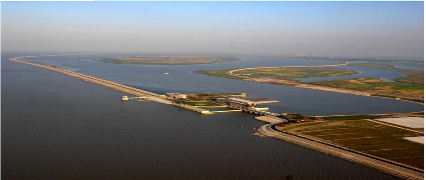
上海青草沙水库及取输水泵站工程是2010年世博会重大保障工程长江口青草沙水源地项目的核心工程，位于长江口南北港分流口下方。主要由中央沙库区、青草沙库区、水库弃泥区、取排水泵闸以及输水泵闸等工程组成，工程等级为 I 级，水库库区总面积约
